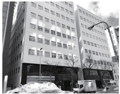
北海道通信ビル（左）と同第二ビル
